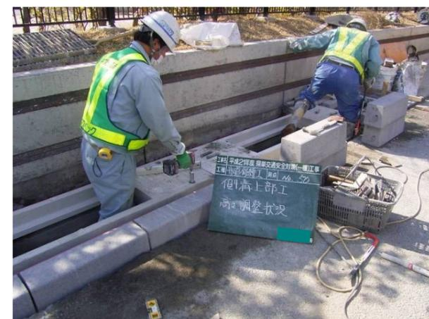
側溝(歩道路面)改修製品設置・高さ調整
