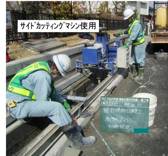
既設側溝壁横断面切断状況
