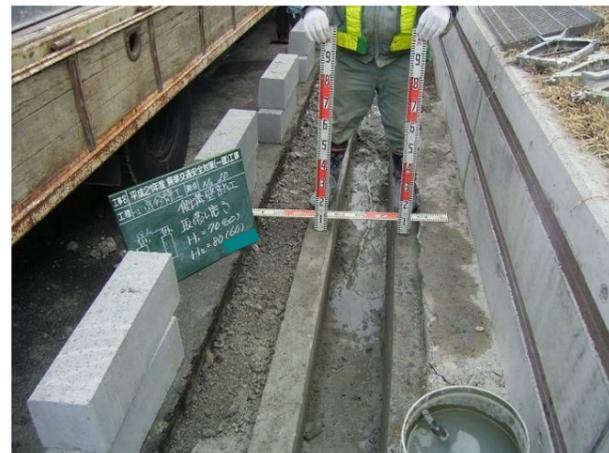
既設水路壁横断面切断・コンクリート撤去完了
