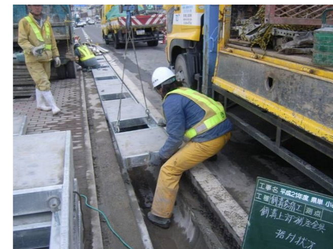
7. 側溝上部補強金具据付状況
