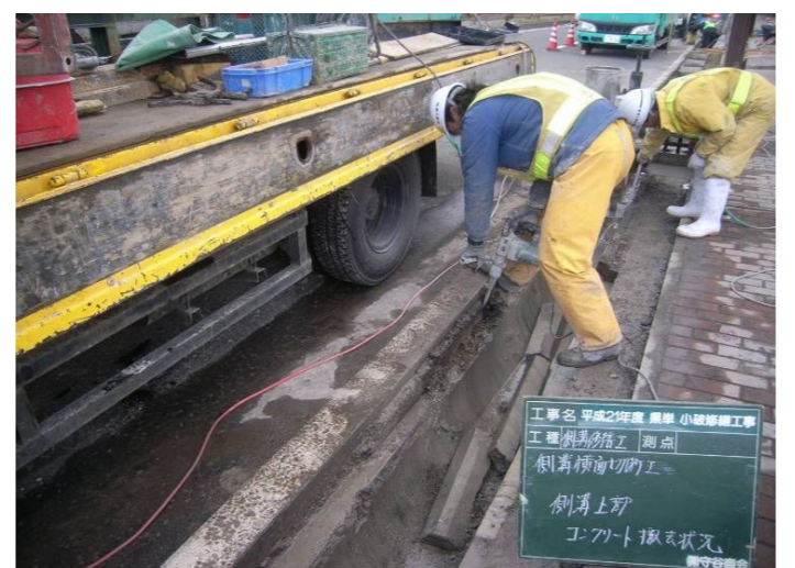
4. 既設側溝上部コンクリート撤去(人力・小機械併用)
