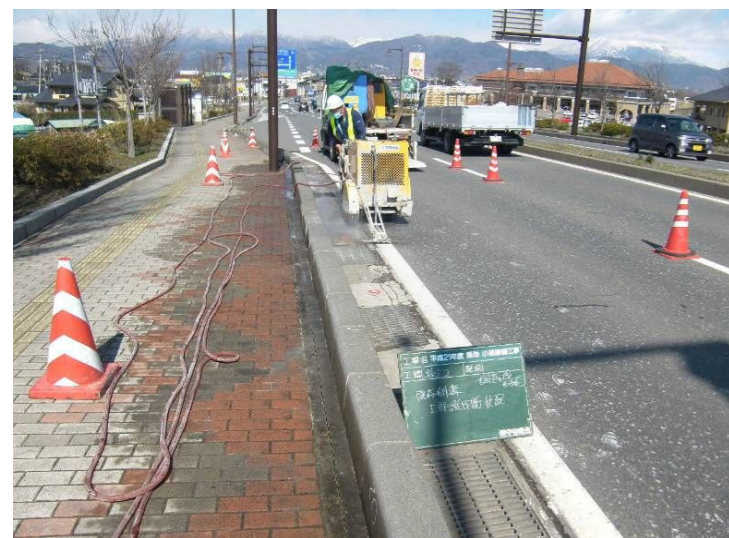
1. 側溝スラブ切断状況
