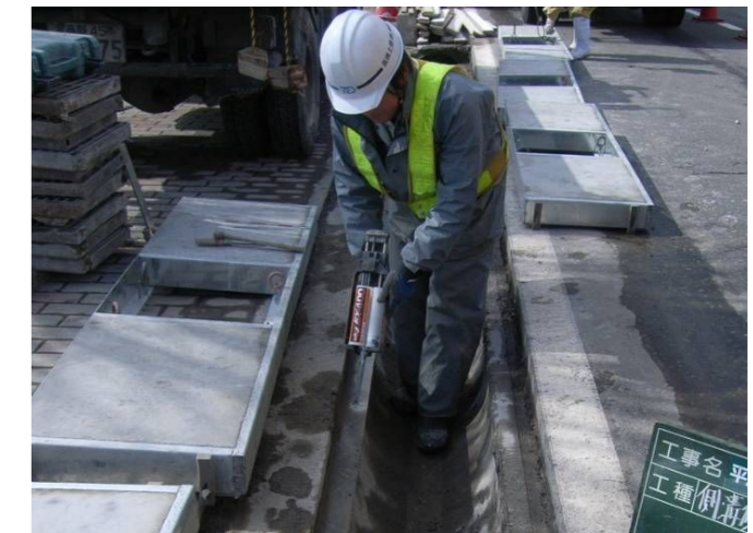
6. ボルト孔エポキシ接着剤注入状況
