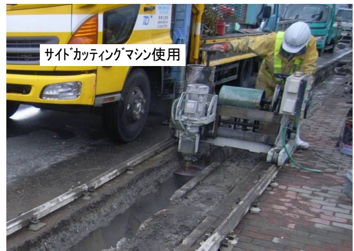
3. 既設側溝上部横断面切断状況
