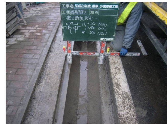
5. 既設側溝上部コン撤去完了
