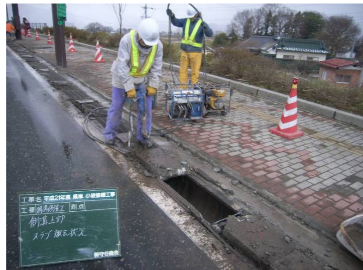
2. 既設側溝スラブ取壊し状況
