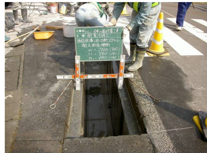
4. 既設側溝上部コンクリート撤去完了
