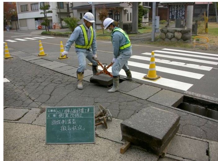
1. 既設側溝蓋撤去状況
