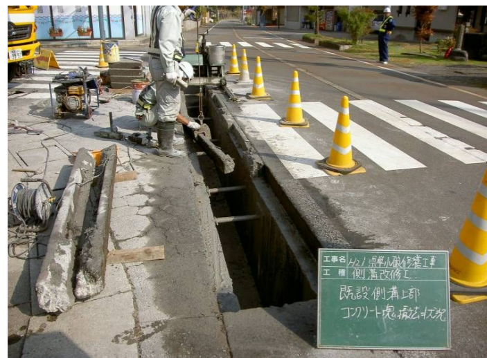
3. 既設側溝上部コンクリート撤去状況
