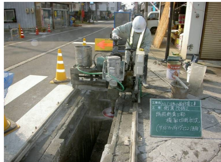
2. 既設側溝上部横面切断状況
