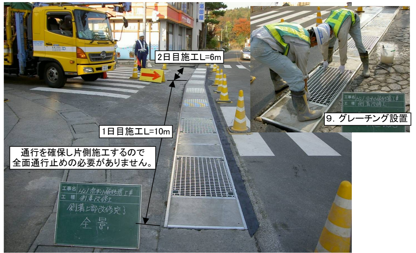
10. 側溝上部改修完了
