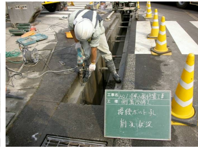
5. 接続ボルト孔削孔状況
