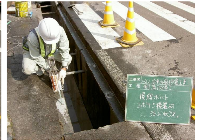
6. ボルト孔エポキシ接着剤注入状況
