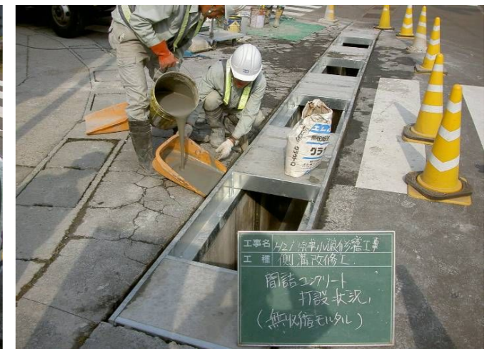
8. 調整間詰めコンクリート打設状況 (速硬化無収縮モルタル)
