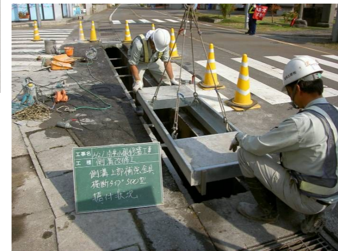
7. 側溝上部補強金具据付状況
