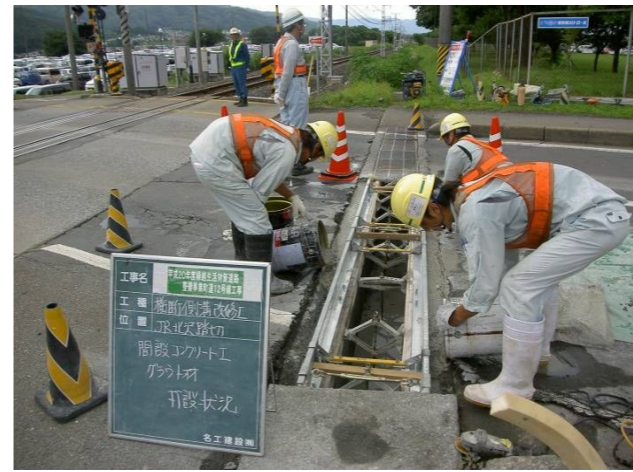
8. 調整間詰めコンクリート打設状況 (速硬化無収縮モルタル)
