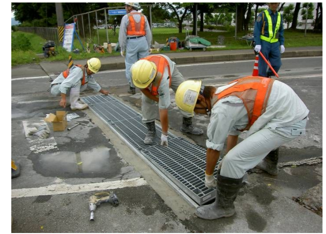
9. グレーチング設置状況
