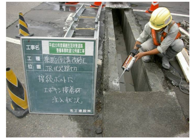
5. ボルト孔エポキシ接着剤注入状況
