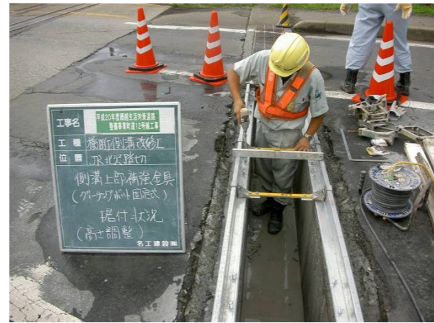
6. 側溝上部補強金具据付状況
