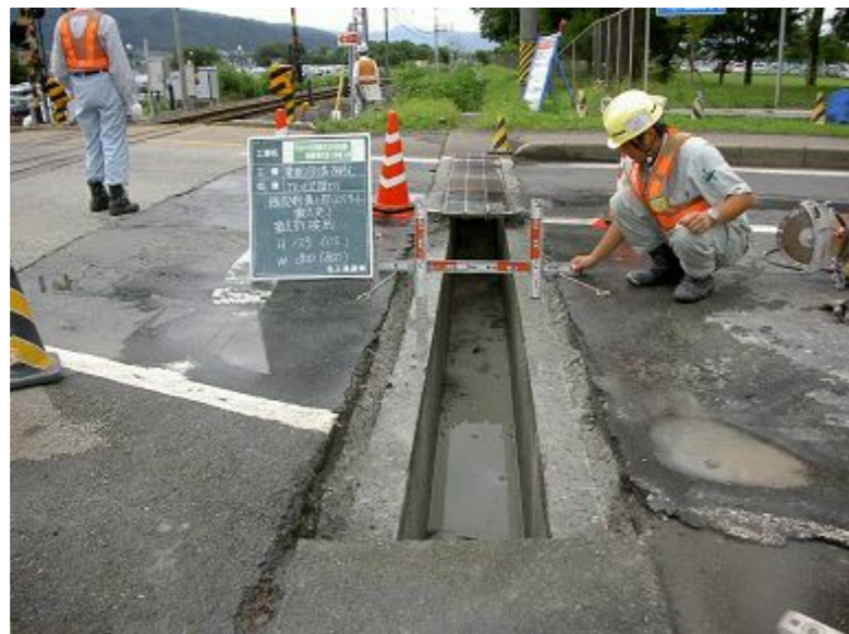
3. 既設側溝上部コンクリート撤去完了
