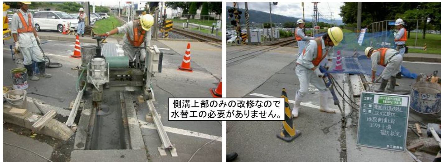
1. 既設側溝上部横断面切断状況
