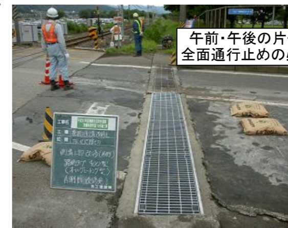
10. 側溝上部改修完了(片側部)
