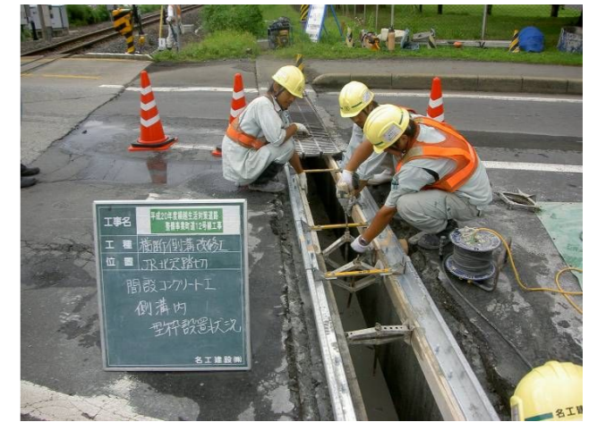
7. 間詰コンクリート用 内型枠
