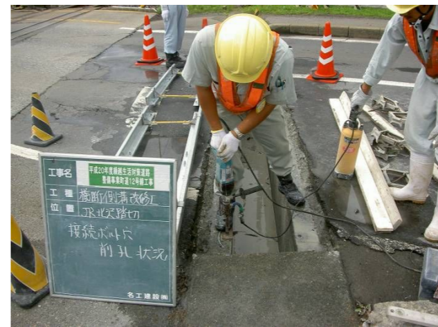
4. 接続ボルト孔削孔状況
