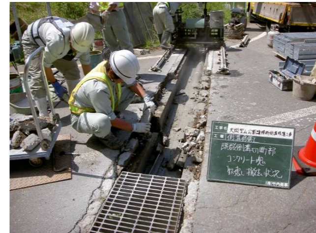
4. 既設側溝上部切断部コンクリート撤去
