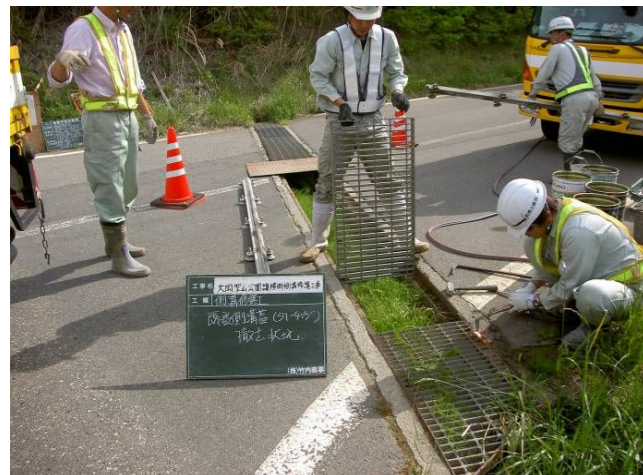
1. 既設側溝グレーチング撤去
