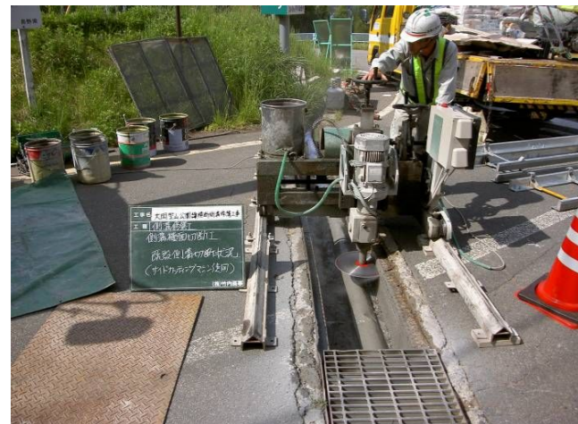
3. 既設側溝上部横断面切断状況
