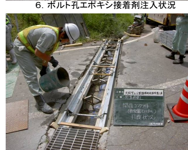
8. 調整間詰めコンクリート打設状況 (速硬化無収縮モルタル)
