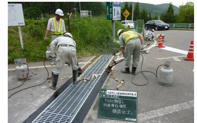
11. すり付け舗装(特殊弾性舗装)状況
