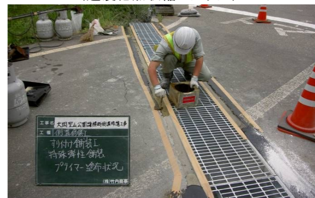
10. 特殊弾性舗装(すり付け)前、プライマー塗布状況
