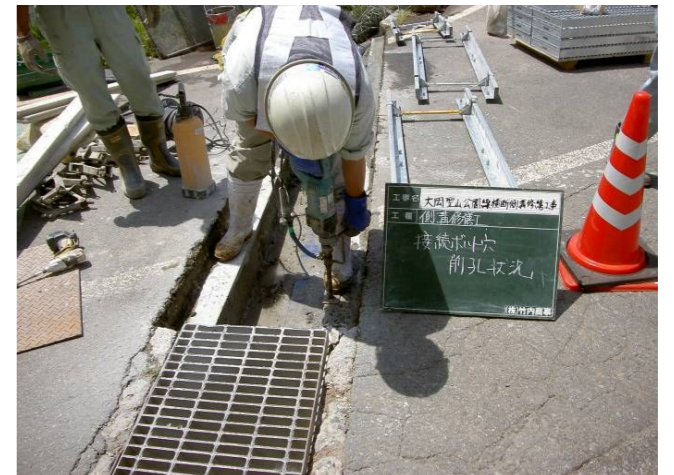
5. 接続ボルト孔削孔状況
