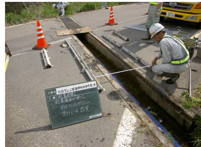
2. サイドカッティングマシン用走行レール設置
