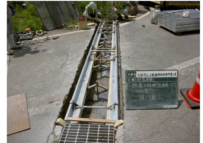
7. 側溝上部補強金具据付完了
