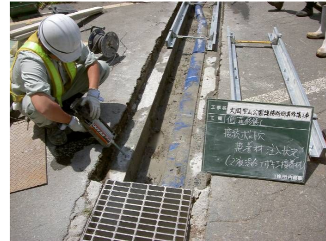
6. ボルト孔エポキシ接着剤注入状況
