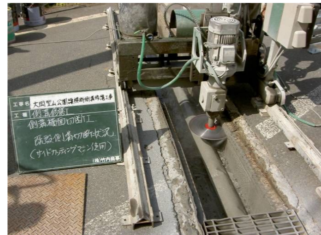
3. 既設側溝上部横断面切断状況
