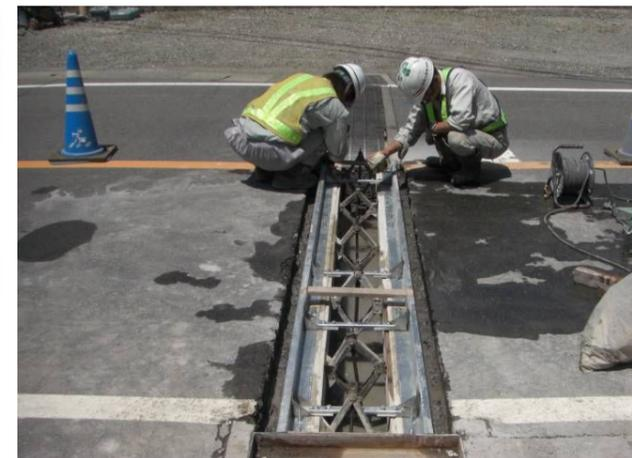
グラウト材充填前型枠設置状況
