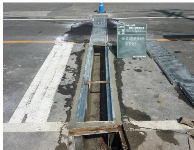
側溝上部補強金具設置完了
