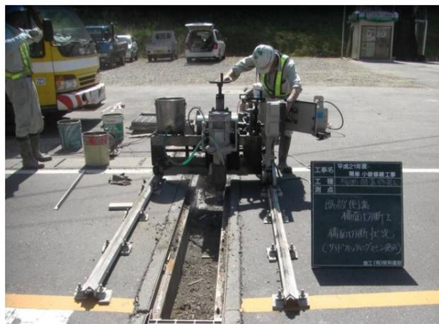
既設側溝上部横面切断状況
