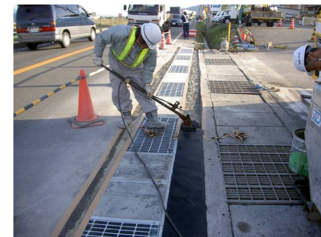
すり付け舗装(特殊弾性舗装)状況
