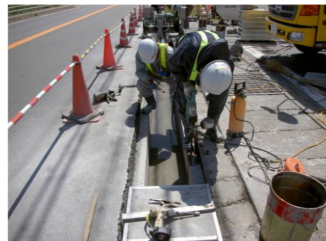
接続ボルト用穴 削孔状況
