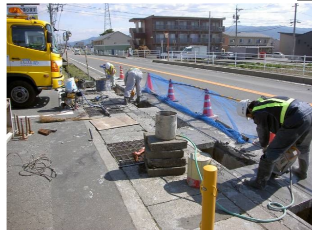
既設側溝蓋およびスラブ取壊し撤去
