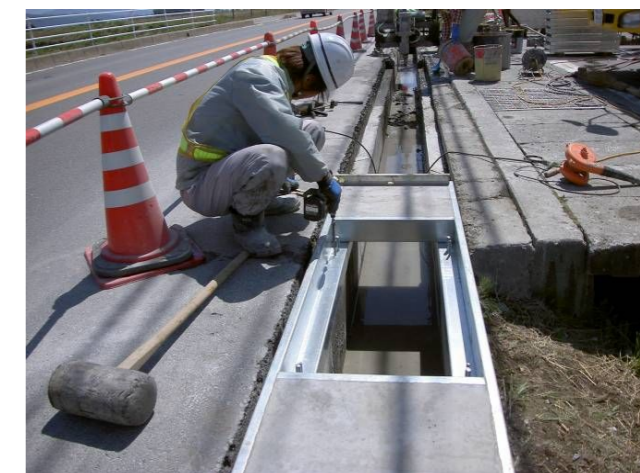
側溝上部補強金具据付・高さ調整状況
