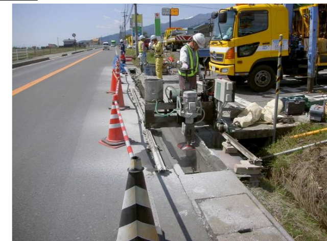
サイドカッティングマシンによる既設側溝切断
