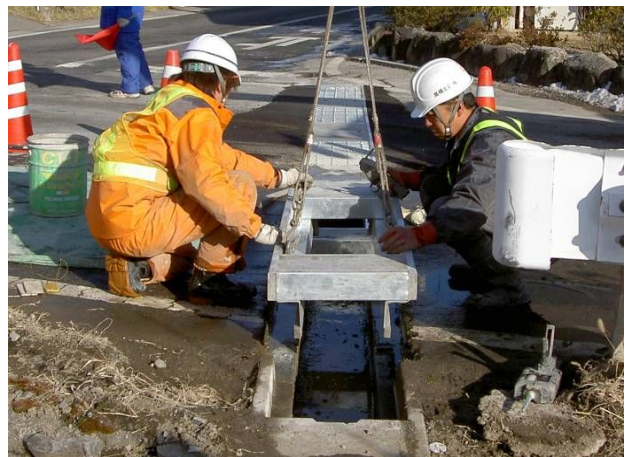
側溝上部補強スラブ設置状況
