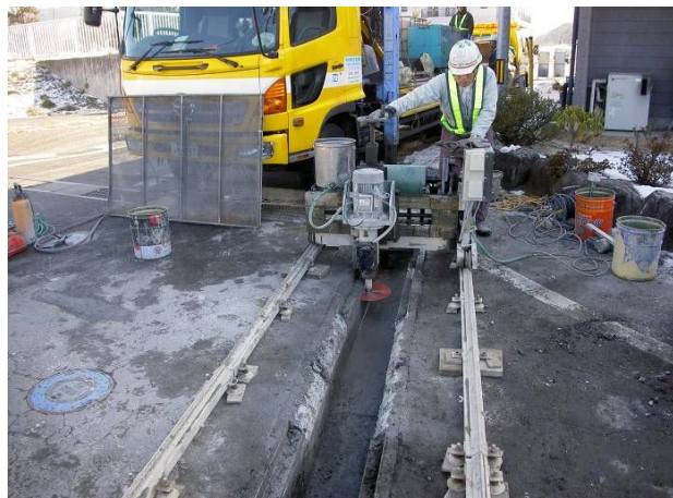
既設側溝上部横断面切断状況
