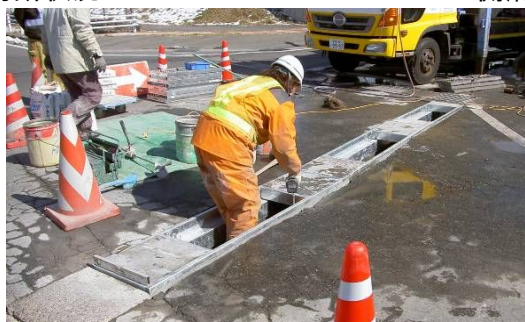
側溝上部補強スラブ高さ調整状況
