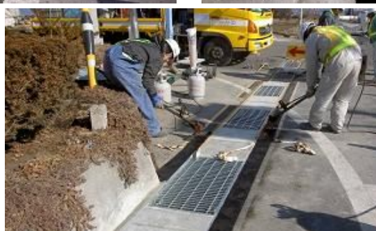
すり付け特殊弾性舗装状況
