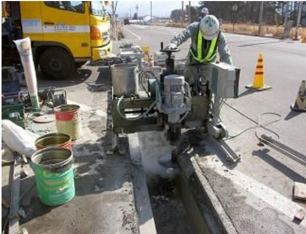
既設側溝上部横面切断状況
