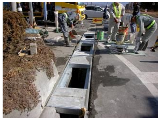
調整間詰めコンクリート打設
