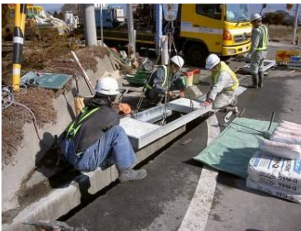
側溝上部補強スラブ設置
