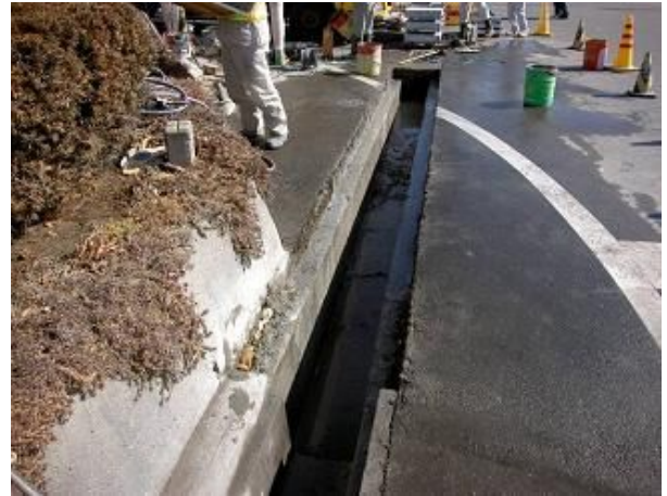
既設側溝上部横面切断撤去完了
