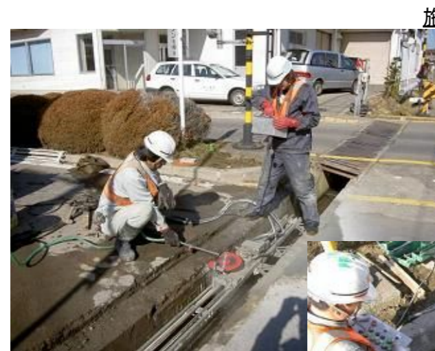
既設側溝上部横断面切断状況
