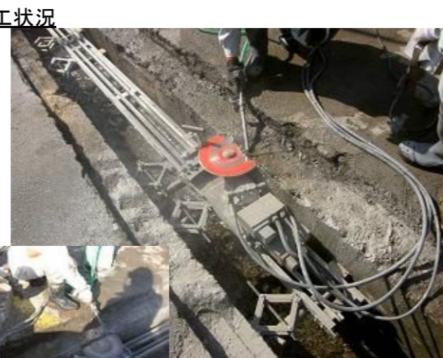
既設側溝上部横断面切断状況
