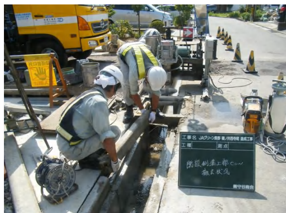
切断部コンクリート塊撤去
