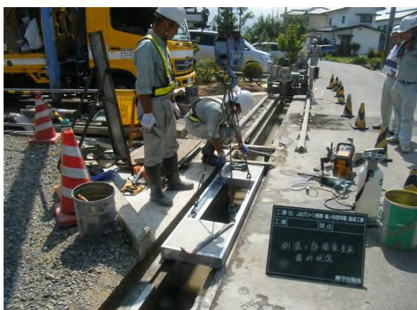
側溝上部補強金具設置
