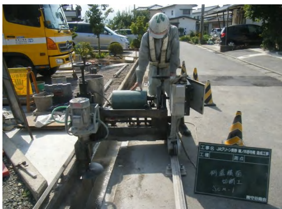
側溝上部切断状況
