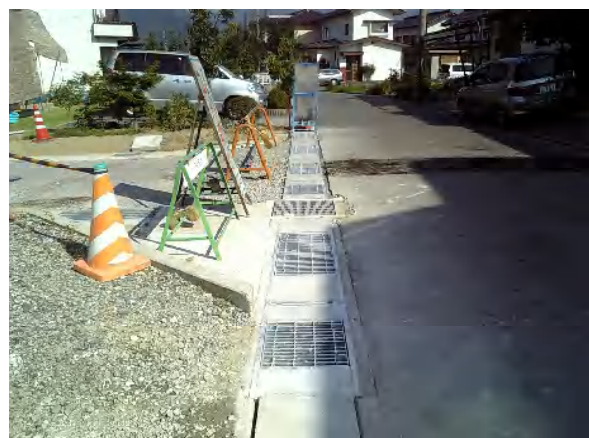
グレーチング設置
