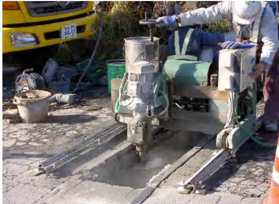
既設側溝横断面切断
