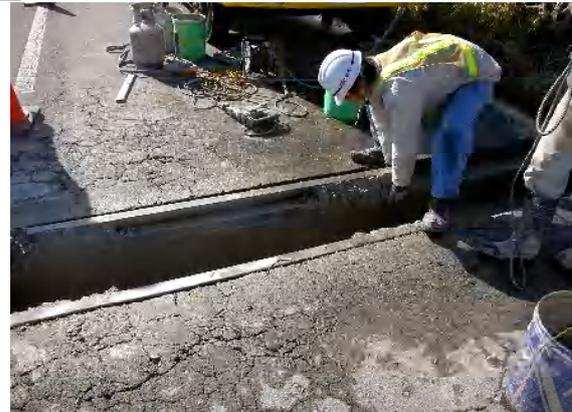
切断コンクリート塊撤去
