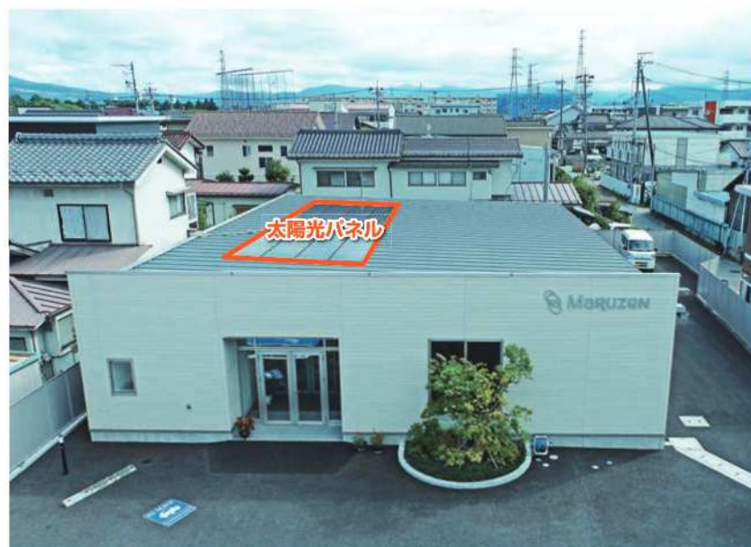
松本市内建設 事務所ビル
