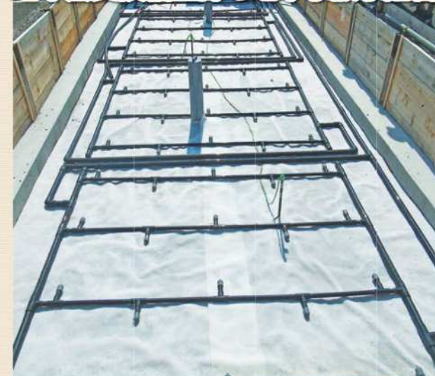
地中熱交換槽上部の地下水散水配管
