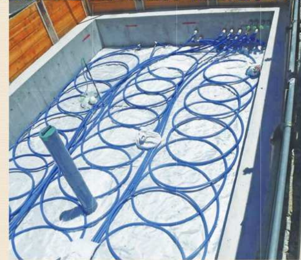
地中熱交換槽上部の地下水散水配管
