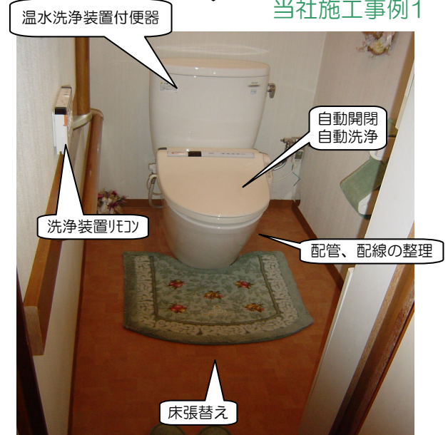
施工後:水洗化完了
