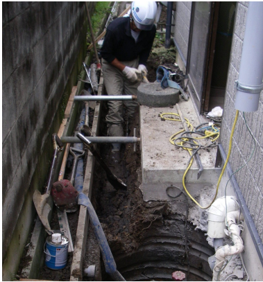
外部埋設配管施工中
