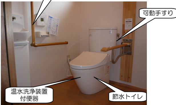
施工後:バリアフリートイレ
