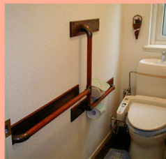
階段・廊下やおトイレに移動や立上りのための手摺を設置
